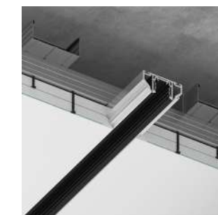
Монтаж в два слоя гипсокартона
